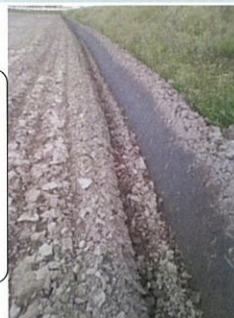
漏水防止のための畦畔補修
