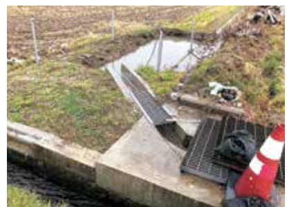
洗浄液等の処理場所設置
